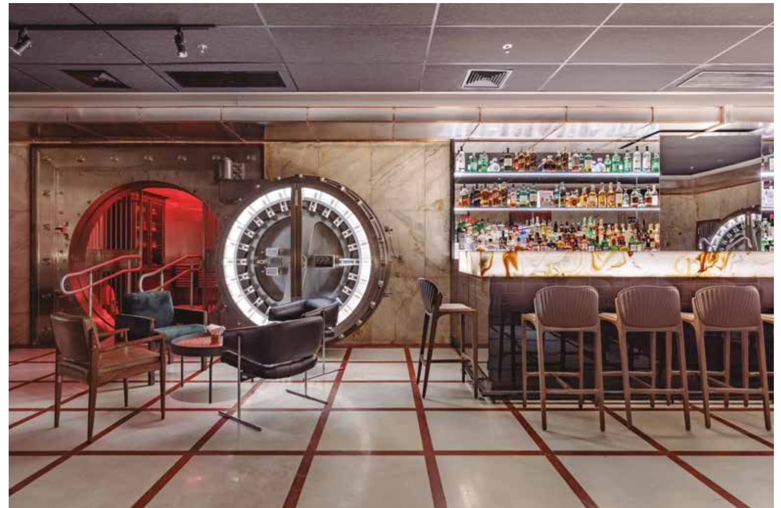
O Salão 1, cujos pontos focais são a porta circular do antigo cofre, ressaltada por meio de mangueira LED neon 7 W/m, 200 lm/m, 2.700 K integrada em seu perímetro; o balcão do bar, transluminado por meio de perfis de LED 9,6 W/m, 810 lm/m, 2.600 K instalados em seu interior; e as prateleiras onde são expostas as garrafas, destacadas por meio de perfis de LED 9,6 W/m, 810 lm/m, 2.600 K, fixados sob cada uma delas, iluminando os líquidos contidos nos envases coloridos.
