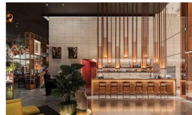
Acima, à esquerda, os nichos da estante são iluminados por fitas LED em perfis de alumínio com difusor translúcido, 12 W/m, 890 lm/m, 2.700 K. À direita, o volume central é destacado por luminárias lineares com corpo de alumínio, lente colimadora de acrílico com abertura de fecho de 30° para iluminação rasante, LEDs 16 W/m, 1.135 lm/m, 2.700 K e drivers dimerizáveis DALI.
